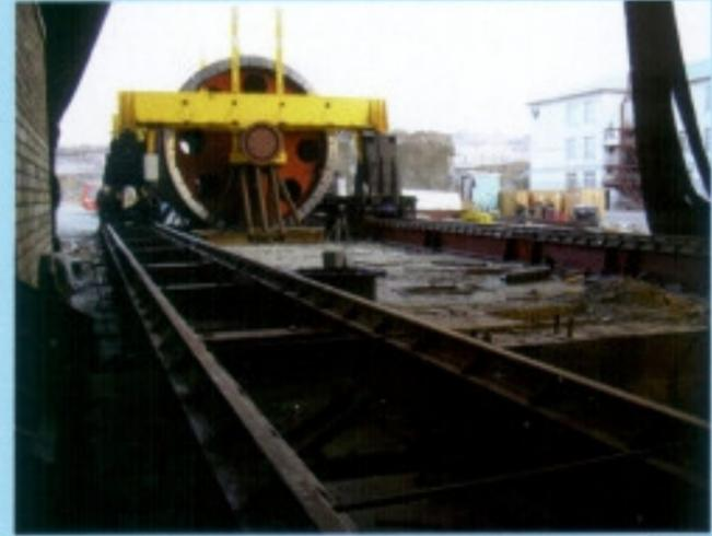
Замена коренной части подъемной машины МПБ-6,3х2,8х2,8 на МПБ-6,3х2,4х2,4Д (оборудованной дисковыми тормозами) Артемьевский рудник, корпорации «КАЗАХМЫС», республика Казахстан
